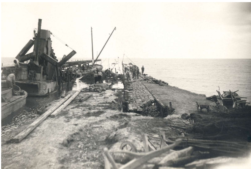
De baggerwerkzaamheden in de haven van Spakenburg in 1932/33, waarbij de havenmonding is verbreed en nieuwe beschoeiingen zijn aangebracht.
